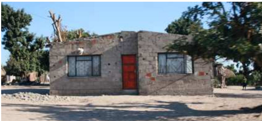
Imagem 1: Casa construída por um emigrante na África do Sul (distrito de Chibuto)
